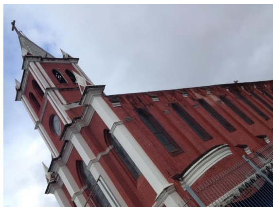
Figura 5.3: Fachada da Igreja de São Sebastião e Santa Cecília
